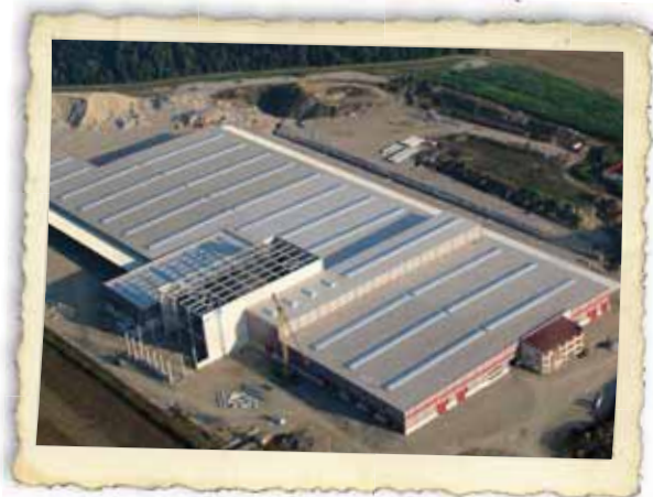
2012/13 Finale Bauphasen auf dem Werksgelände in Mühlendorf
